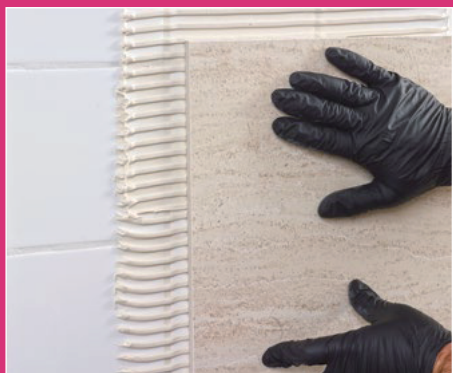
現有磚面 EXISTING TILES
